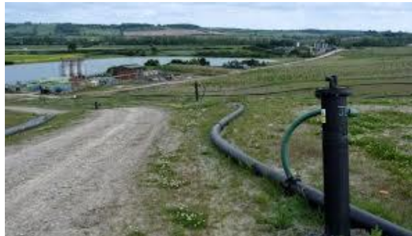
Landfill gas collection
